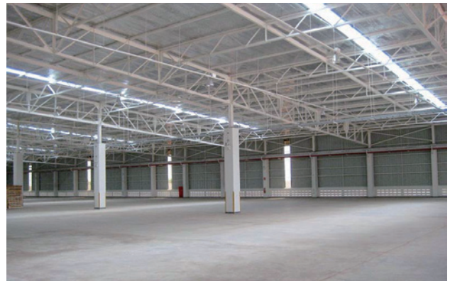
図6 天井採光を配した倉庫内の様子
