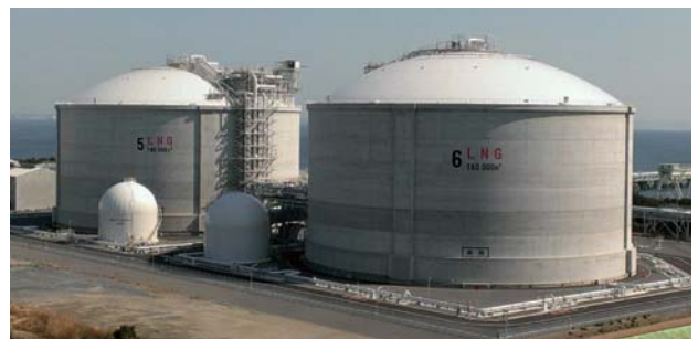
図2 最新のPCLNGタンク（180,000kL） （中部電力㈱殿川越火力発電所）
