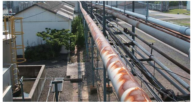
写真4 e'-AIM工法施工前における蒸気配管の外観
