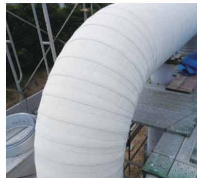
写真8 エルボ部への施工状況（外装板施工前）
