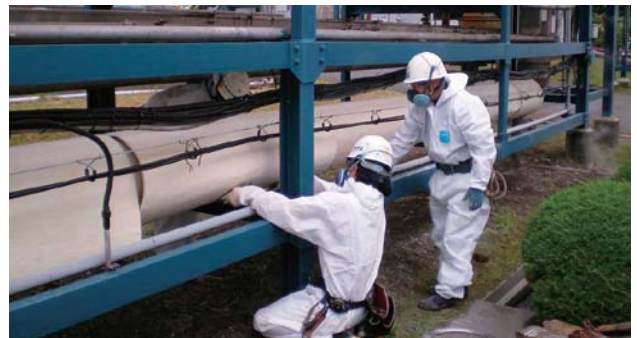
写真6 e'-AIM工法施工状況
