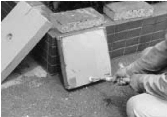
写真8 テスト注入状況
