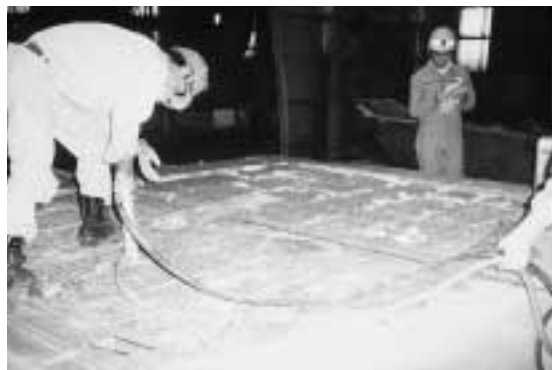
写真11 扉部への施工
