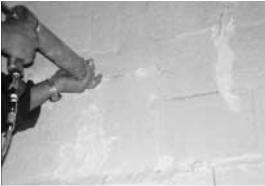
写真6 コーキングガンによる充填
