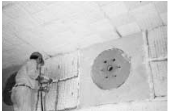
写真10 側壁部への施工
