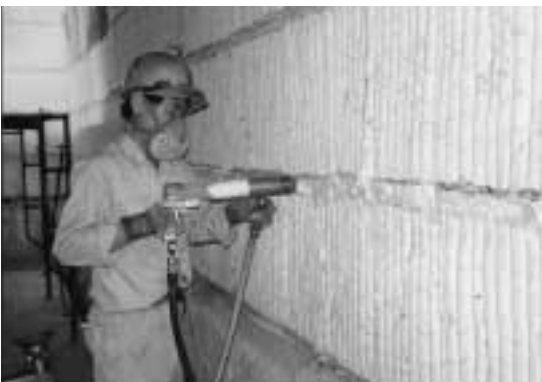
写真4 特殊ノズルによる施工
