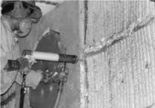
写真3 ノズル内への充填
