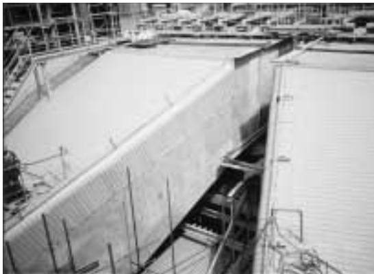
写真4 絞りダクトでの施工例
