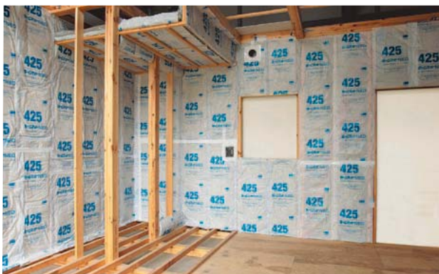
図4 ホームマットNEO施工写真
