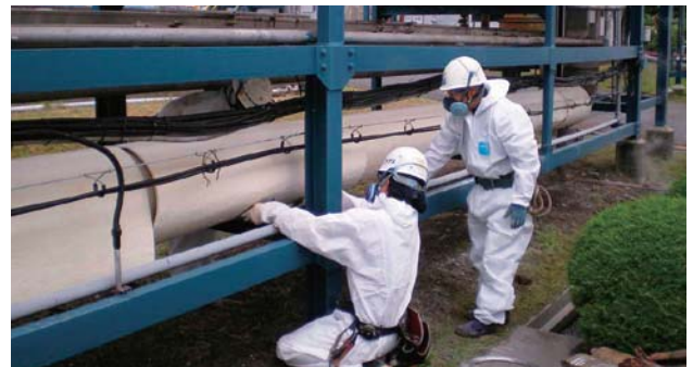
写真6 e-AIM工法施工状況
