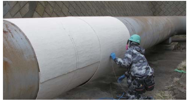
写真7 水平配管への施工（パイロジェルXTを施工中）
