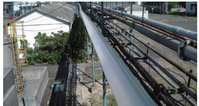
写真5 e-AIM工法施工後における蒸気配管の外観
