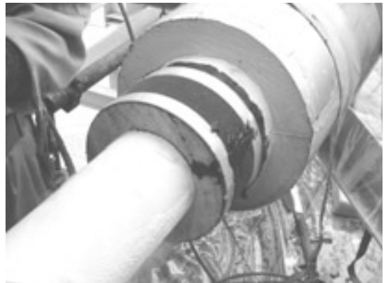
写真2 既設保冷材との境界部分の内層保冷材の施工後外観
