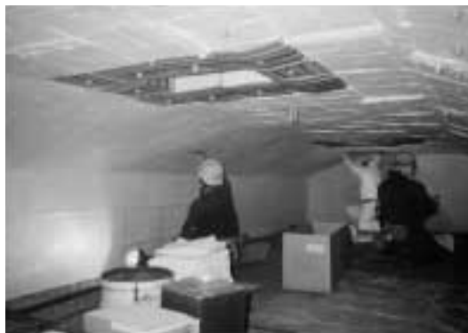
写真6 実炉施工写真
