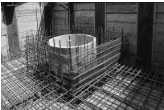
写真1 鉄筋コンクリート造煙突施工状況
