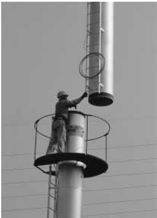
写真2 鋼製煙突施工状況
