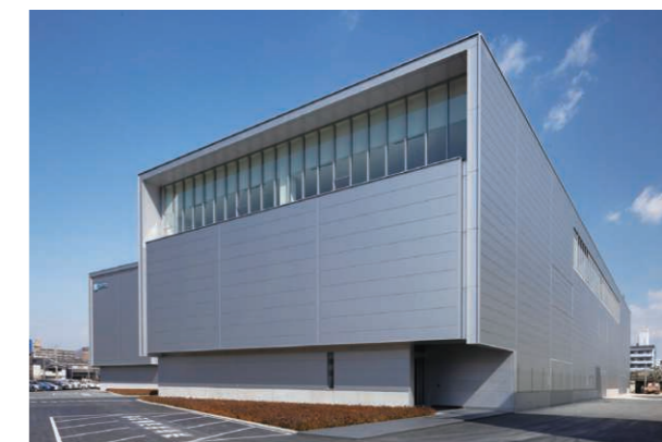
2022年4月に竣工した王寺工場第2号棟
