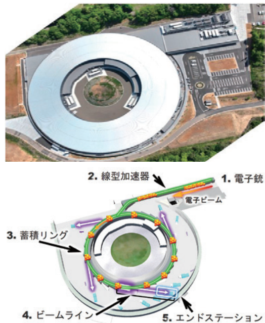
図6 ナノテラスの線型加速器、蓄積リング、ビームライン、エンドステーションの配置
