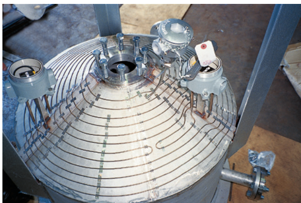
図6 タンクへのMI型ヒータ施工例
