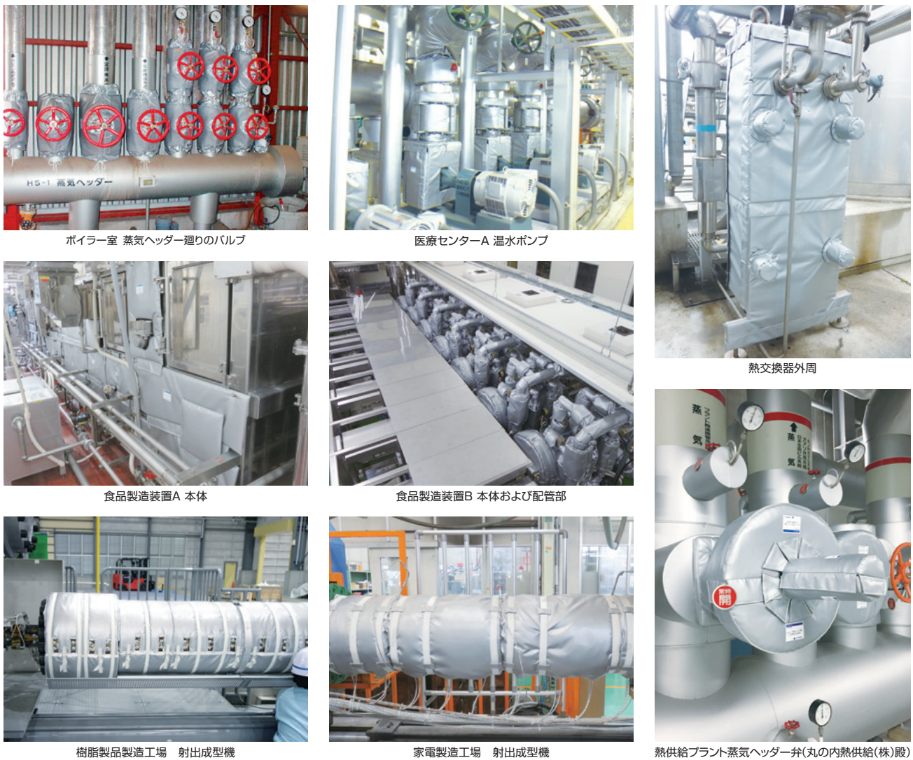
図11 エネサーモ施工事例
