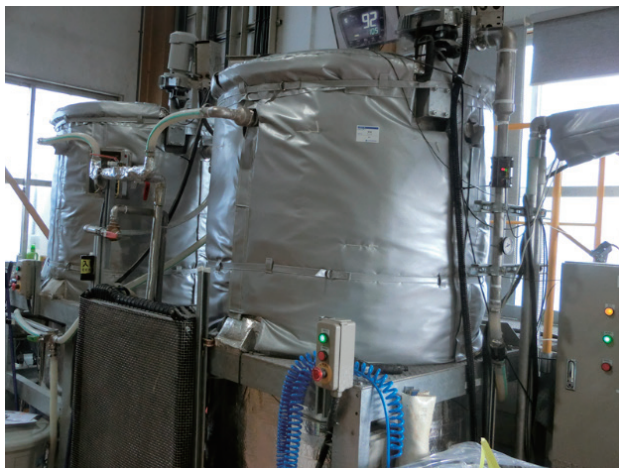
図6 エネサーモ施工例（配管タンク外周へ施工した様子）
