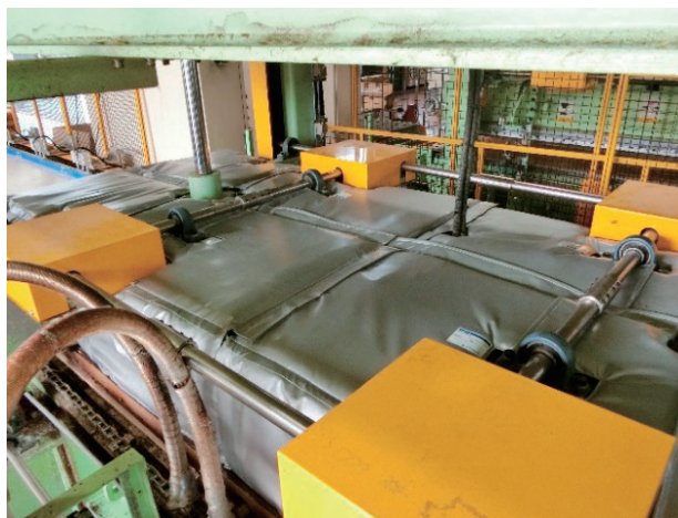
図5 エネサーモ施工例（熱プレス機上面へ施工した様子）
