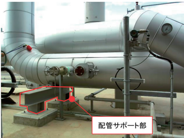
図3 配管と配管サポート部の例
