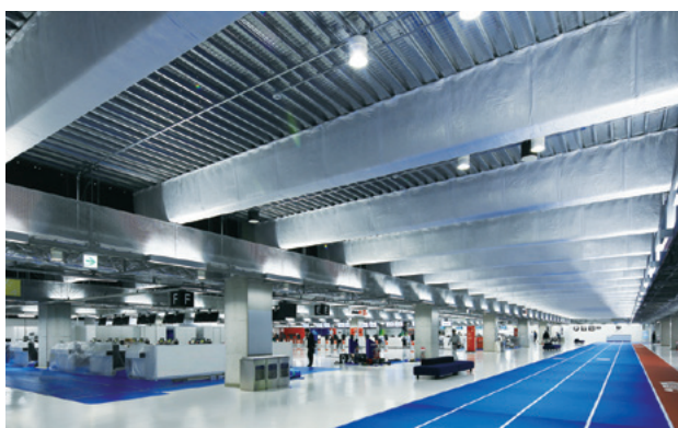
図6 「マキベエ® WTA」梁の施工事例（成田国際空港）
