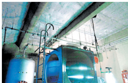
図8 「マキベエ® ダンネット」機械室天井の施工事例
