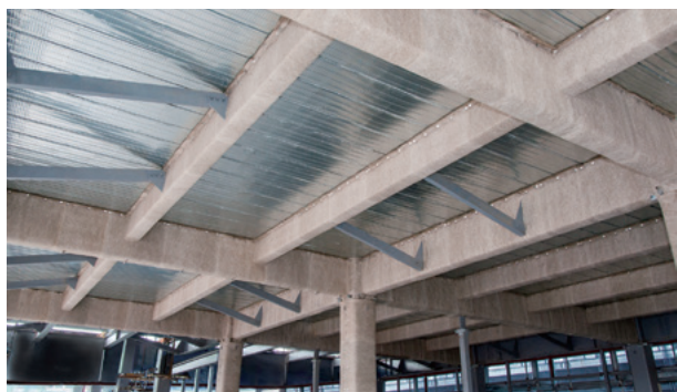
図5 「マキベエ®」梁の施工事例
