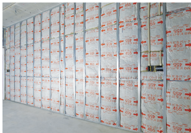
図11 「MGビルパック®」 間仕切り壁施工事例
