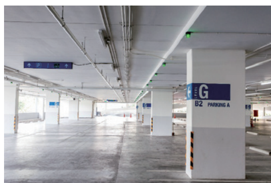
図1-b 店舗駐車場 天井使用部
