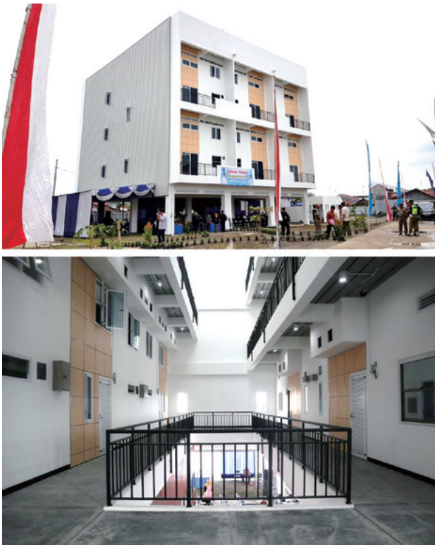
図9 Tegal市に建設した実験住宅“Low-Carbon Passive House I”
