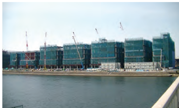
図9 建設中の東京団地冷蔵（2017年4月撮影）
