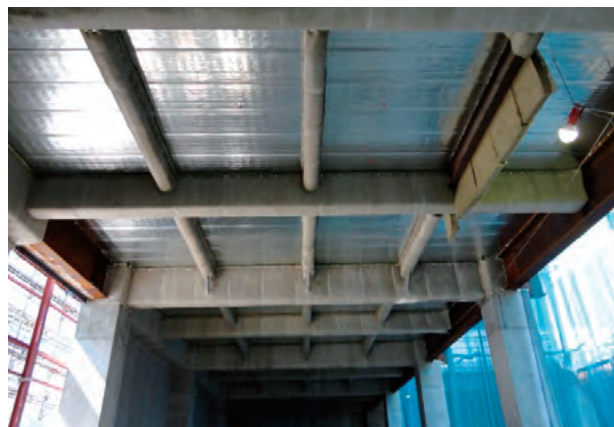
図7 マキベエの施工状況
