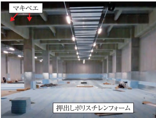
図12 床の防熱工事
