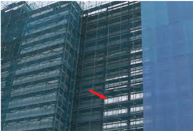
図11 外壁の防熱工事
