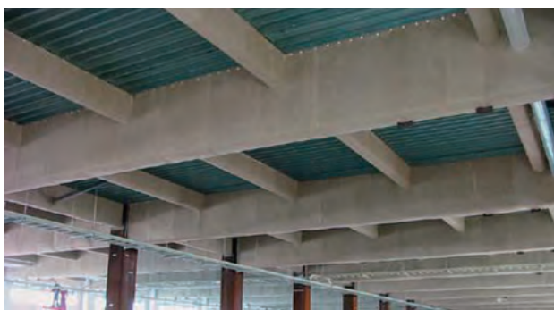
図10 マキベエ施工状況
