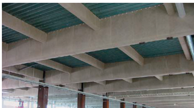
図10 マキベエ施工状況
