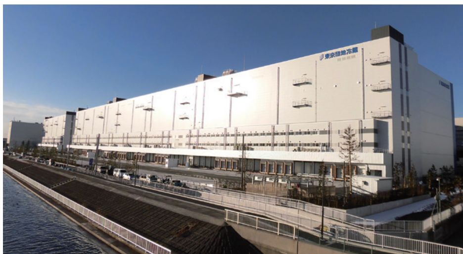
図1 竣工間近の東京団地冷蔵の全景（2018年1月撮影）
