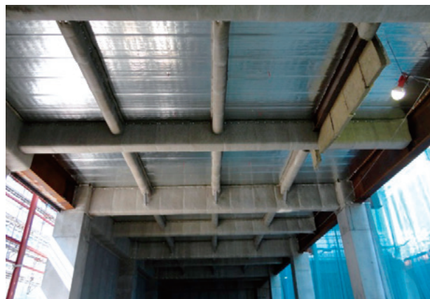
図7 マキベエの施工状況
