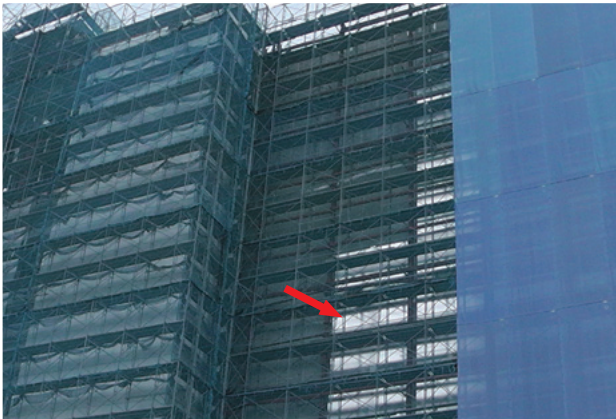
図11 外壁の防熱工事
