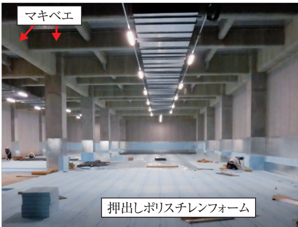
図12 床の防熱工事
