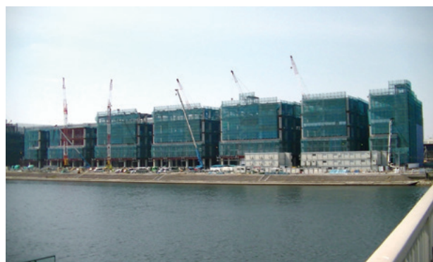
図9 建設中の東京団地冷蔵（2017年4月撮影）
