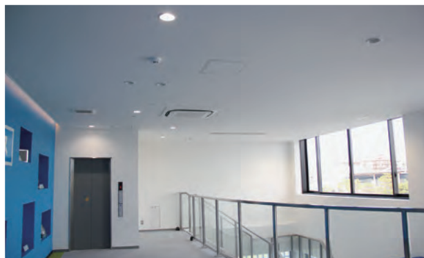
図2 「エコラックス」のビル内装施工例
