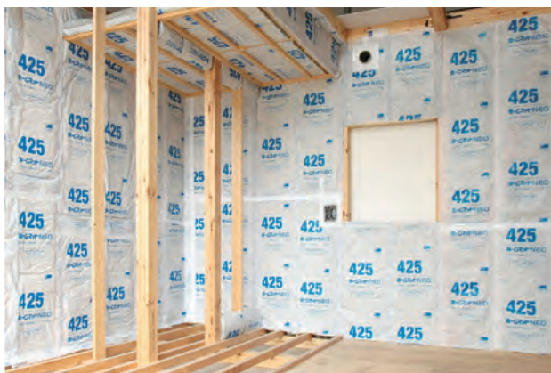
図6 住宅用ロックウール断熱材の施工例
