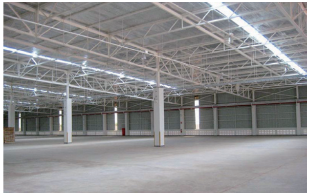
図6 天井採光を配した倉庫内の様子
