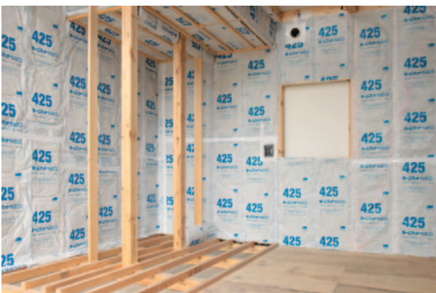
図3 住宅用ロックウール断熱材の施工例
