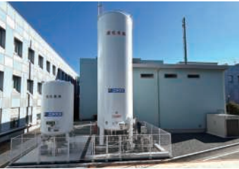
浜松研究所に新設された液化水素実験棟
