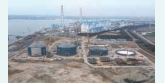
建設中のアンモニア燃料転換設備(提供: JERA)
