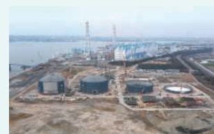
建設中のアンモニア燃料転換設備 (提供: JERA)
