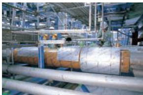
保温保冷工事
