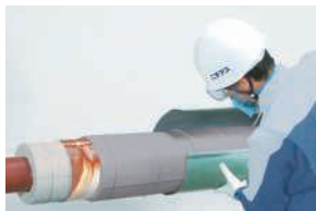
保温機能回復工法
