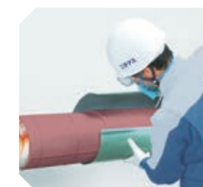
保温メンテナンス工事「増し保温® 工法」
