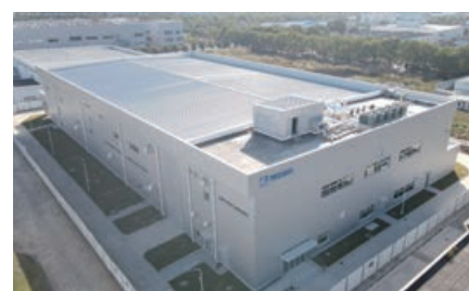
蘇州霓佳斯工業製品有限公司 第3工場 (2024年竣工)
