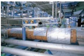
保温保冷工事
