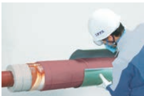
保温機能回復工法
