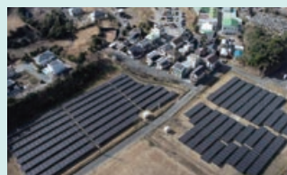
当社遊休地に設置した太陽光発電設備
