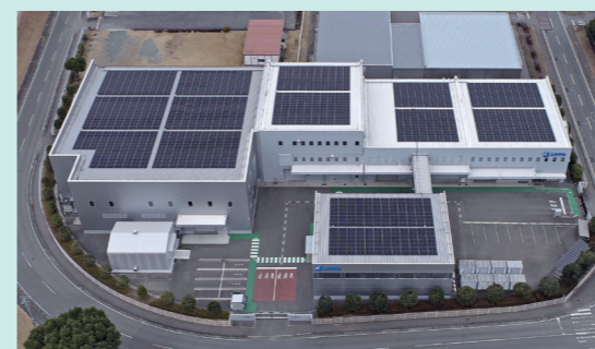
(株)熊本ニチアスの太陽光発電設備
