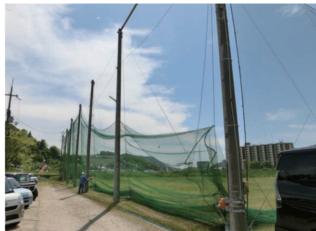
昇降設備が設置されたグラウンド周囲のネット(王寺工場)
