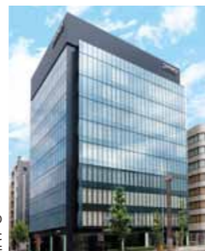
2013年、耐震性、非常時の電源確保への対策が強化されたビルへ本社を移転
