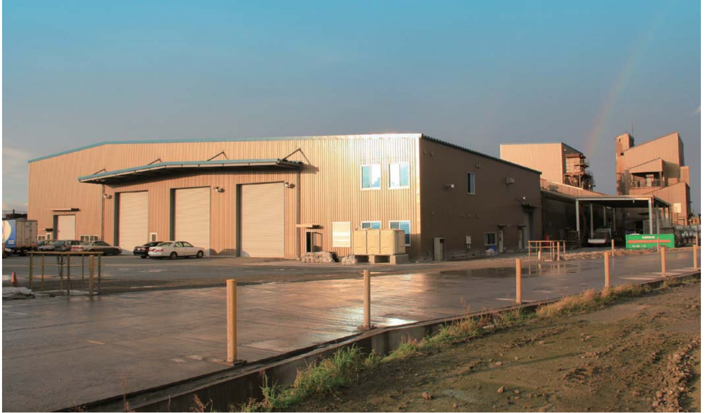
千葉県君津市の新工場
