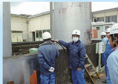
燃料タンクの点検方法確認
