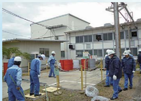
防油溝および周辺の点検
