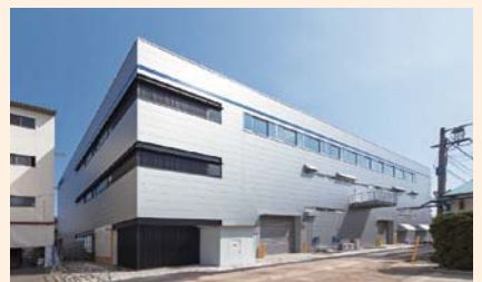
羽島工場新管理棟
