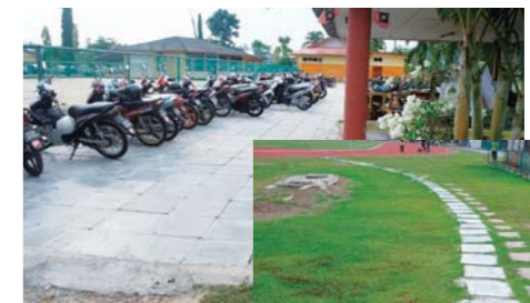
建築用パネルを活かした床・通路
