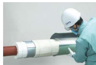
保温機能回復工法 [e'-AIM®工法]
