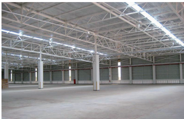
図6 天井採光を配した倉庫内の様子
