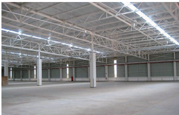
図6 天井採光を配した倉庫内の様子
