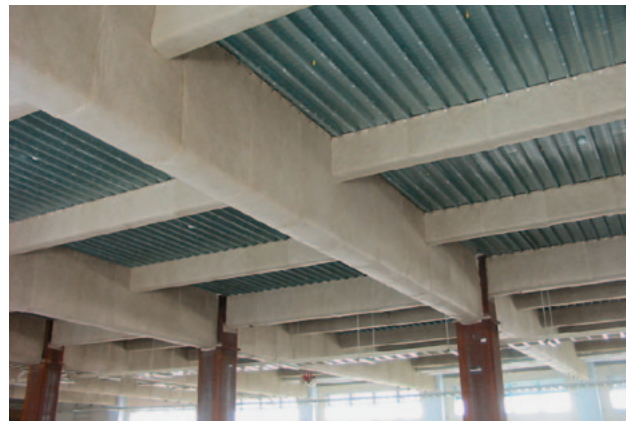
図4 巻き付け工法による耐火被覆の施工例
