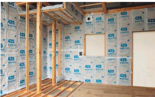
図4 ホームマットNEO施工写真
