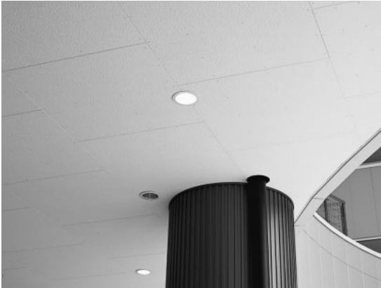
写真2 「エコラックス®」店舗天井での施工例
