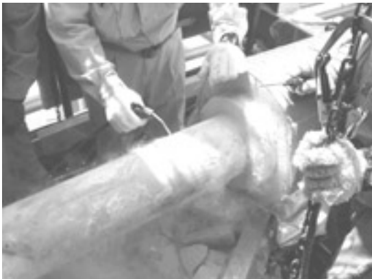
写真1 既設保冷材解体後の配管に付着した霜の除去
