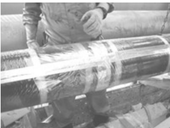
写真3 内層保冷材の取付け及びプラスチックフィルム施工後の外観
