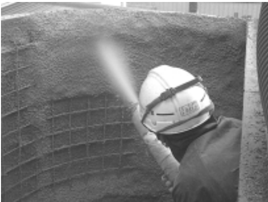
写真6 溶接金網+下地面へSG-50を施工中
