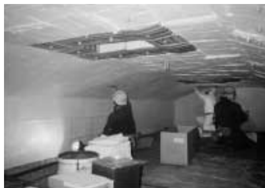
写真6 実炉施工写真
