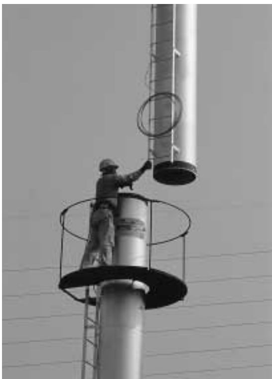
写真2 鋼製煙突施工状況
