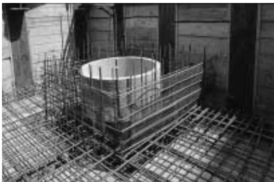
写真1 鉄筋コンクリート造煙突施工状況
