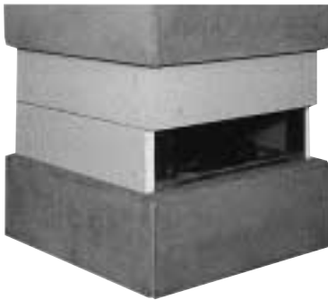
写真6 積層ゴム点検
