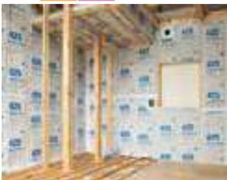
防湿性を持つフィルムを一体化させた住宅用断熱材です。室内外の熱の出入りを断ちます。
