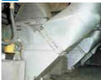
配管やダクトなどの煙風道に使用される、非金属製伸縮継手です。ダクトの熱膨張や収縮を吸収し、煙風の漏れを断ちます。
