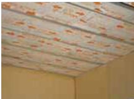
ビルの天井、間仕切壁向けに使用される防音・断熱材です。空調の熱を保ち、天井や壁からの音を断ちます。
