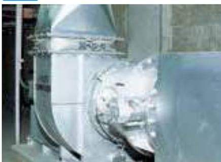
配管やダクトなどの煙風道に使用される非金属製伸縮継手です。ダクトの熱膨張や収縮を吸収し、煙風の漏れを断ちます。
