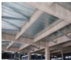
巻付けタイプのロックウール製耐火被覆材
