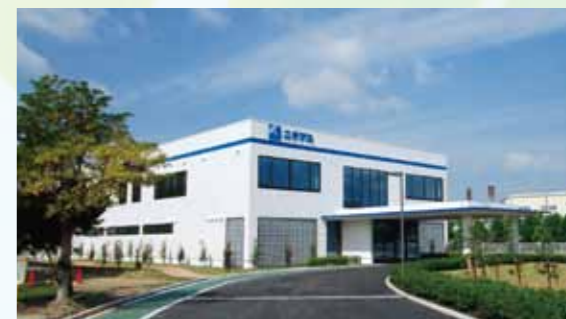
袋井工場の新事務所
