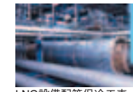
LNG設備配管保冷工事
